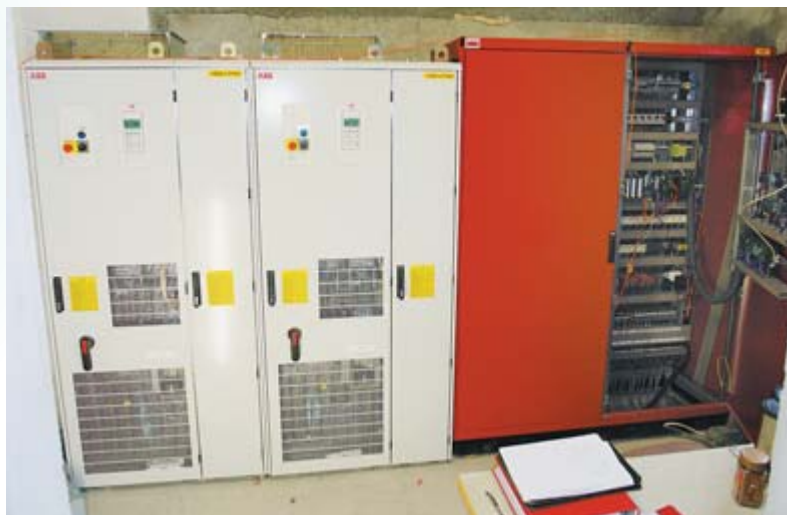
Die kompakte Frey-Steereinheit mit den beiden ABB-Frequenzumrichtern (rechts).
