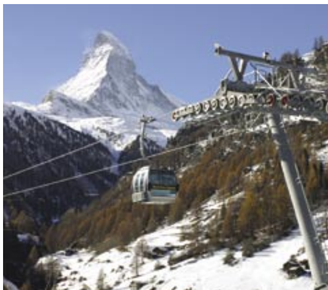
Beide Sektionen des Matterhorn Express in Zermatt sind mit einer Einsprecheinrichtung über das Förderseil ausgerüstet worden.
