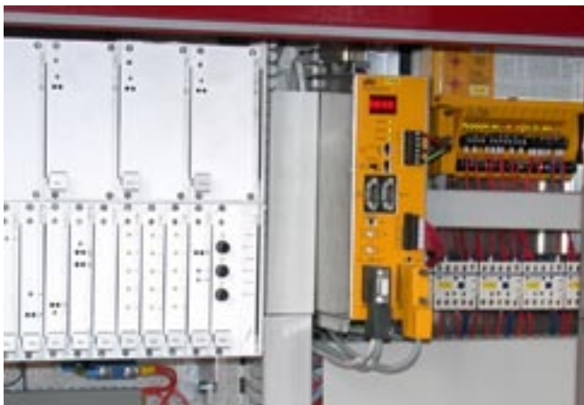
Der Safety Bus ermöglicht die Verarbeitung von mehr als 140 Sicherheitsinformationen in den Wagen.
