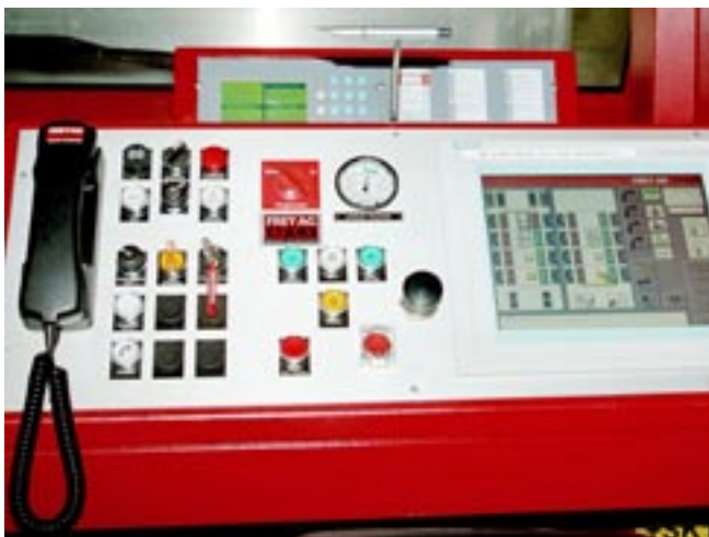
Steuerplatte mit Touchpanel im bergseitigem Führerstand des Wagens.
