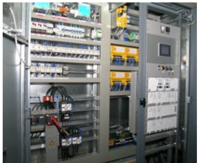
Auf dem kleinen Monitor im Steuerschrank können alle sicherheitsrelevanten Daten abgerufen werden.
