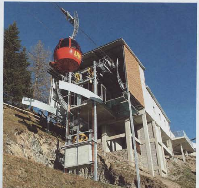
Die Bergstation Feldis der LRF wurde komplett neu erbaut. Zwischen den Fahrbahnen das Zugseil-Spanngewicht mit 8,75 Meter Spannweg. Fotos: tb
