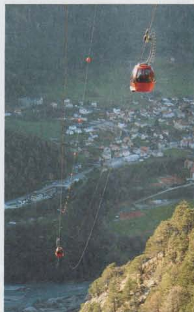
Bergab öffnet sich jäh das Tal ab Stütze 1. Die dort installierte Rettungsbahn erreicht beide Kabinen.
