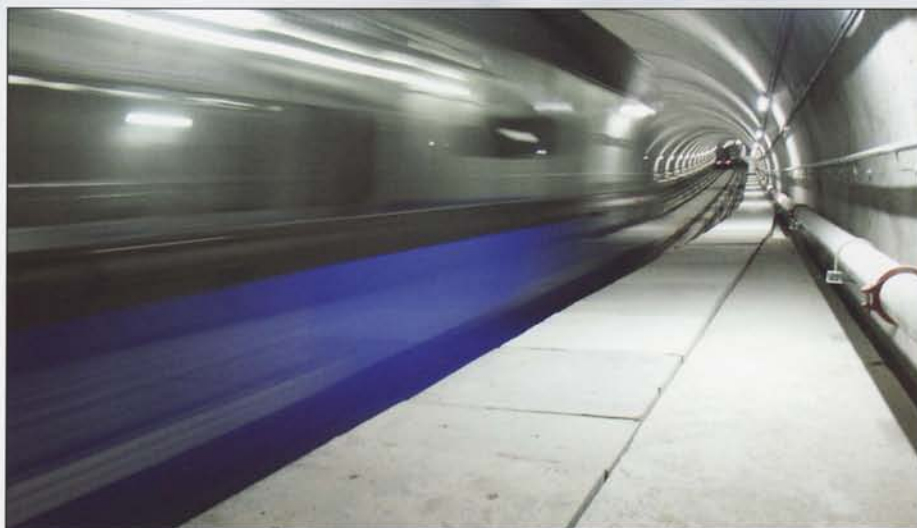
Die neue unterirdische Standseilbahn befördert ihre Passagiere (jeder Zug hat eine Gesamtkapazität von 375 + 1 Personen) in nur 110 Sekunden von der Talstation Kabataş am Hafen zum Taksimplatz, wo es Umsteigemöglichkeiten zur Metro, Straßenbahn oder Buslinien gibt. Täglich pendeln mehrere Millionen Personen von der asiatischen zur europäischen Seite und wieder zurück.
