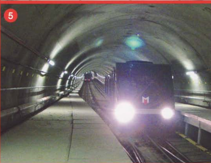
Bild 5: In der Mitte der Strecke kreuzen sich die beiden Zugkompositionen auf einer Abtschen Ausweiche, d. h. sie fahren auf einem kurzen Stück nebeneinander.
